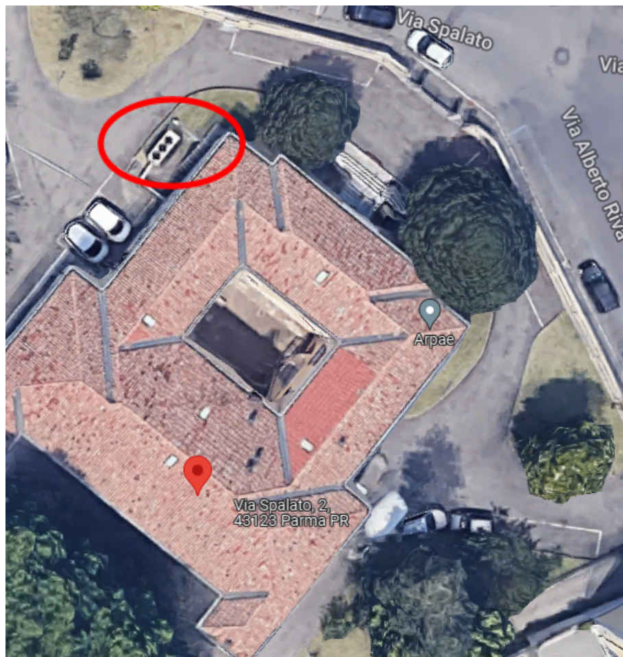
Figura 1 Sito di installazione
