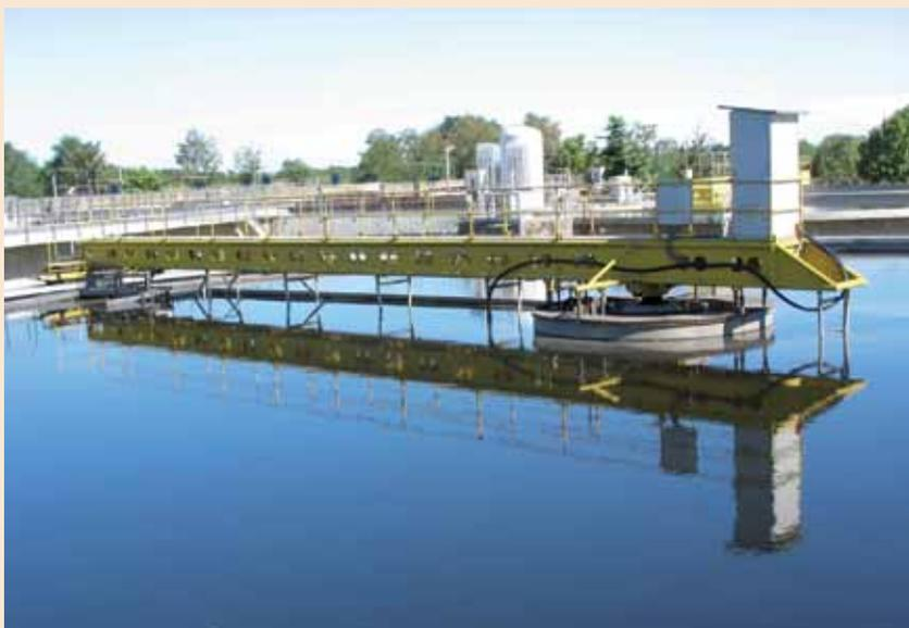
Impianto di depurazione acque reflue di Cervia, vasca di sedimentazione
