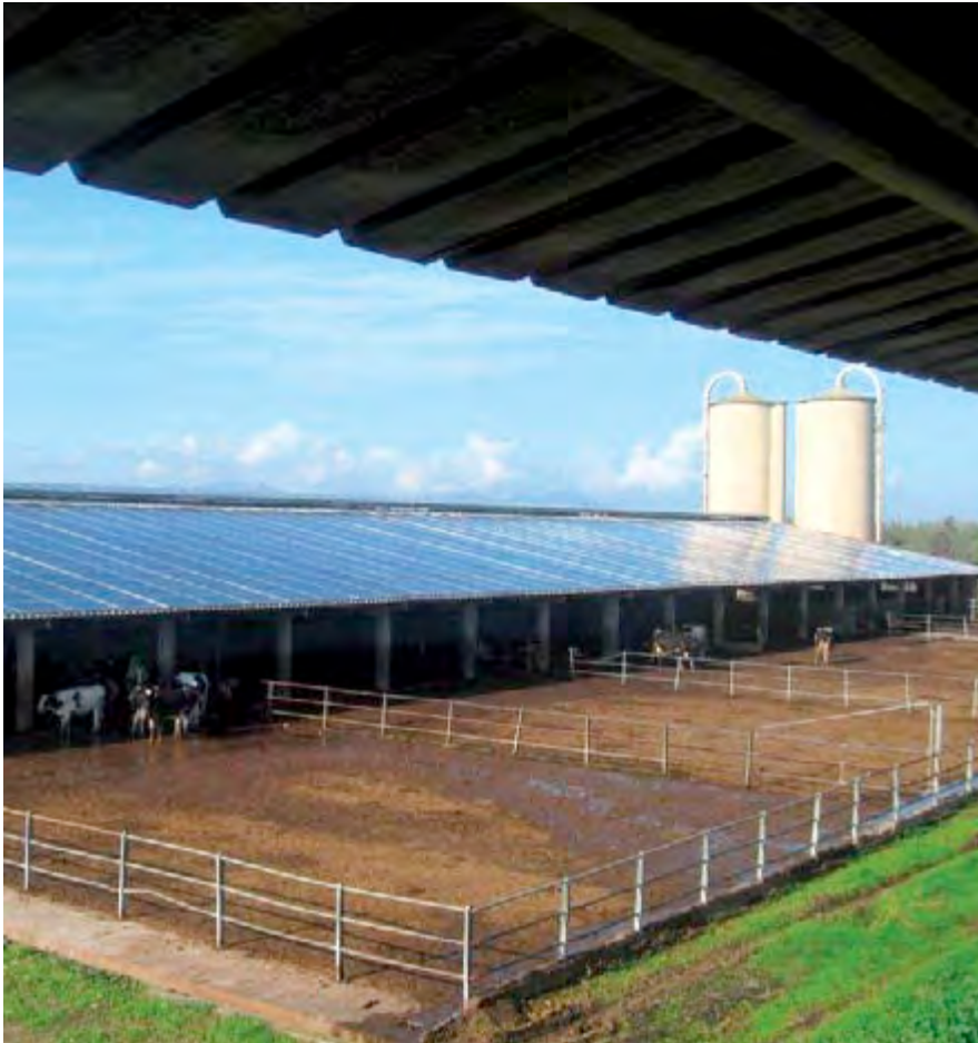
La Regione Emilia-Romagna ha finanziato la sostituzione dell'eternit con fotovoltaico nelle stalle e altri servizi agricoli.
