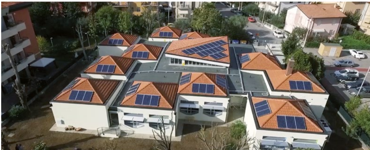
Riqualificazione energetica della scuola materna La Gabbianella di Rimini, che l'ha resa edificio Nzeb (Nearly zero energy building).
