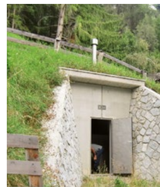
FOTO: ARCH. APPA BOLZANO
