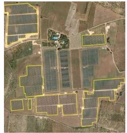
FIG. 2 FOTVOLTAICO A TERRA Installazione nel comune di Palo del Colle - Bari (Snpa, 2022).
