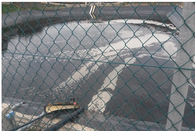
Foto 3: Vasca 3 per la raccolta del percolato
