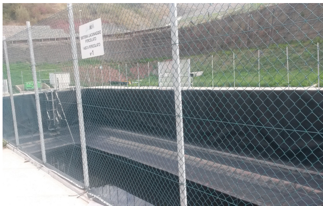
Foto 1: Vasca 1 per la raccolta del percolato
