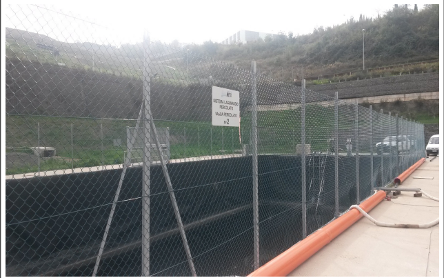
Foto 2: Vasca 2 per la raccolta del percolato
