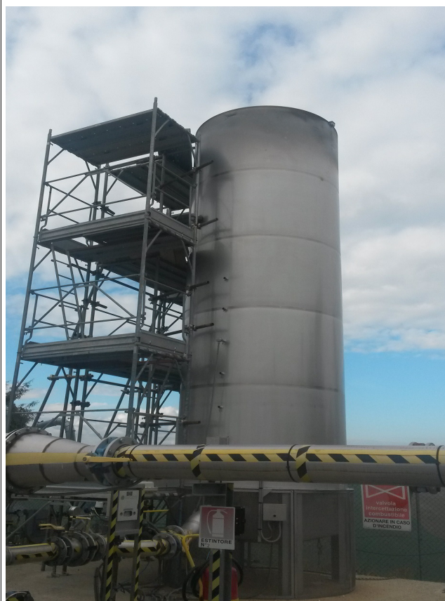
Foto 9: Torcia di combustione biogas
