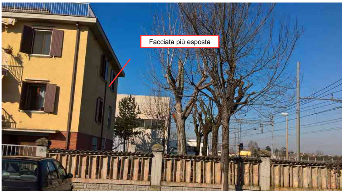
Foto 4: Abitazione e relativa facciata indagata
