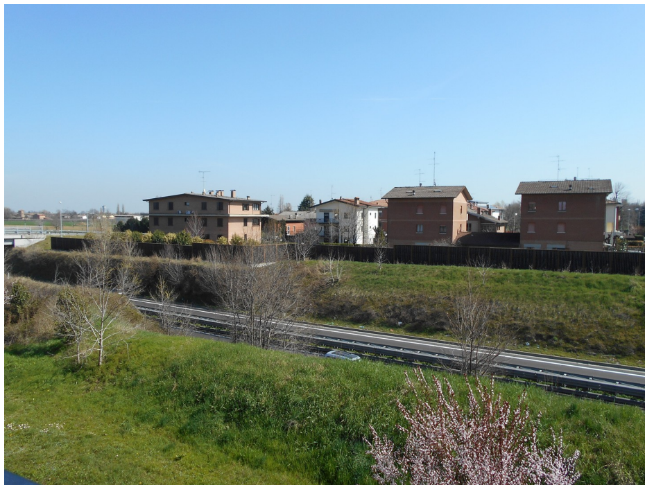
Figura 4: Superstrada Modena-Sassuolo vista dal punto di monitoraggio
