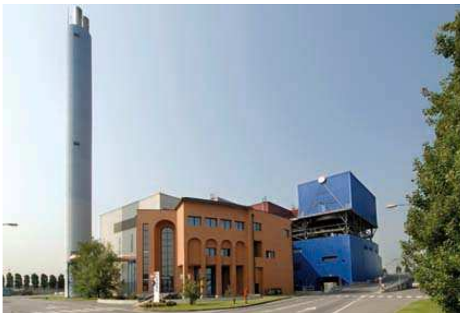
Figura 22: Impianto di termovalorizzazione di Piacenza (Fonte: Iren Ambiente)
