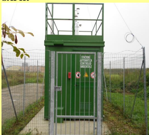
Stazione: Porto S. Vitale (Ravenna) ex SAPIR
