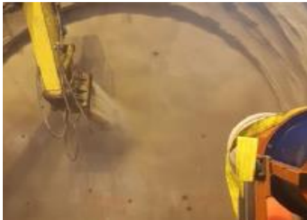
Figura 1 – Nebulizzazione fronte di scavo
