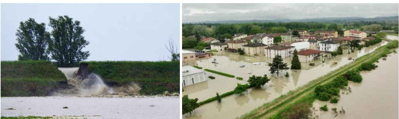
Figura 4: Rotta arginale sul torrente Sillaro (a sinistra) ed allagamenti nella città di Faenza causati dalla piena del Lamone (a destra).
