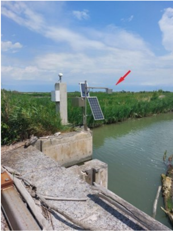
Figura 9 - Sensore mareografico radar in prossimità del faro di Goro (freccia rossa).
