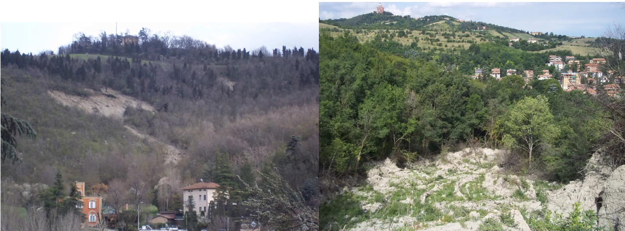
Figura 8: Gli imponenti movimenti franosi che hanno interessato il tratto terminale del bacino del Ravone in aprile 2013. Una vasta porzione di bosco (circa 2 ettari) si è staccata dal versante nord-ovest del colle dell'Osservanza (foto a sinistra) originando una colata di fango e tronchi che si è incanalata lungo la vallecchia di un affluente del Ravone (foto a destra).
