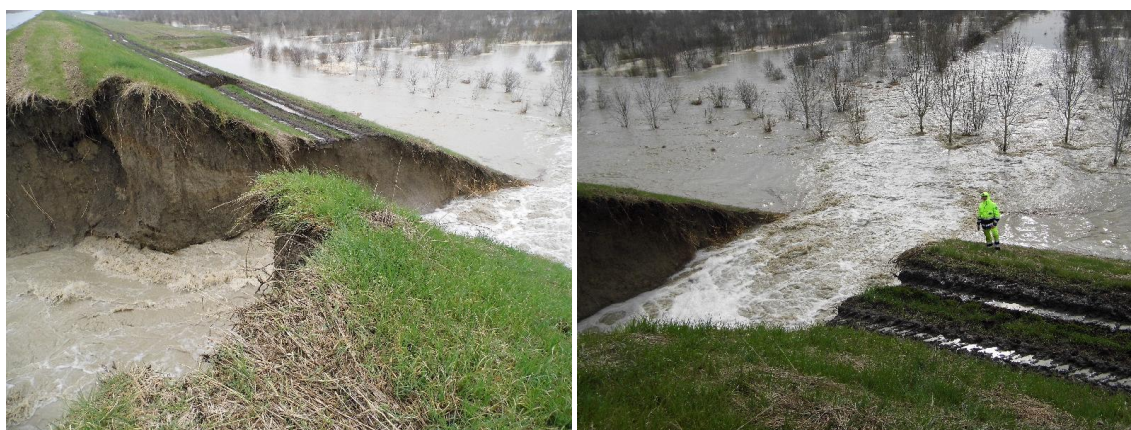
Figura 8: La rottura dell'argine del torrente Quaderna nel Bolognese. (Da Il Resto del Carlino).
