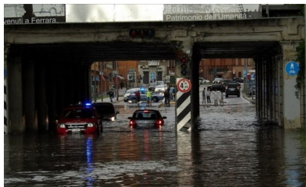
Figura 19: Allagamento di un sottopasso a Ferrara, da "La Nuova Ferrara".
