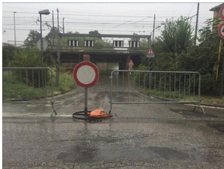
Figura 10. L'allagamento di un sottopasso nel Faentino (da Faenza.net).
