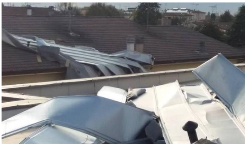
Figura 16. Un tetto scoperchiato dal forte vento a Finale Emilia, da Il Resto del Carlino Modena .
