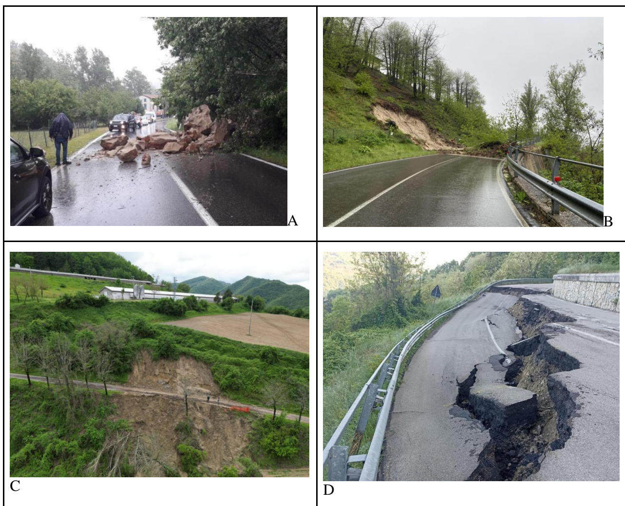
Figura 41: A e B: frane di monte su viabilità: A: Monterenzio , fondovalle Idice, B: Loiano, SS 65 Futa; C e D: frane che hanno danneggiato le infrastrutture: C: Casola Valsenio, strada Comunale; D: Monzuno, SP 59.
