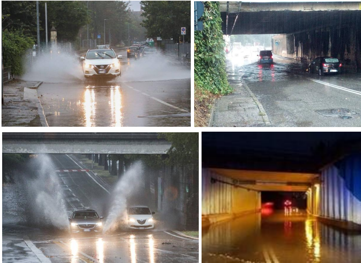
Figura 24: Strada allagata a Bologna a sinistra e sottopasso di via Masserenti a destra in alto, sottopasso di via Gagarin in basso a sinistra, sottopasso di via del Triumvirato in basso a destra. (fonte: www.ilrestodelcarlino.it ; www.24emilia.com )
