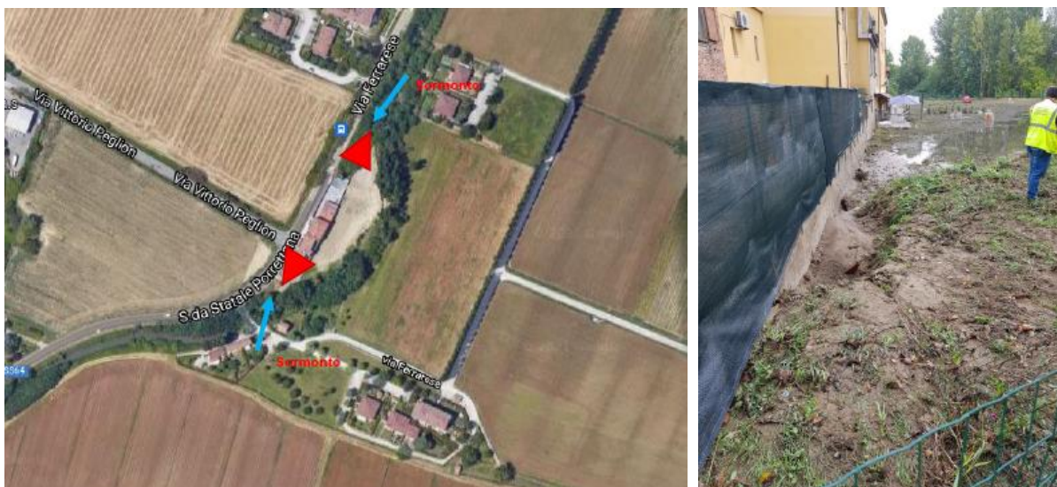
Figura 21: Allagamenti localizzati causati dai sormonti arginali sulla sponda sinistra del Savena abbandonato
