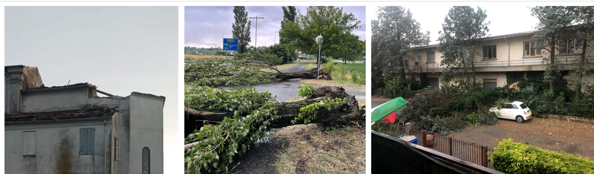
Figura 15: Danni in provincia di Parma alla chiesa di Frescarolo a Busseto, a Fidenza e a Soragna (fonte: ParmaToday.it ).
