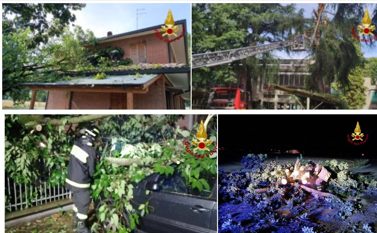
Figura 16: Alberi caduti sulla tettoia di un edificio nel Comune di Gattatico, sulla scuola “Dalla Chiesa”, su un’automobile in località Reggio Emilia ( www.reggionline.com ) e in una strada del Parmense. ( www.ilparmense.net ).
