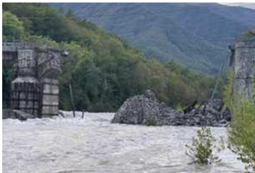
Figura 31: Crollo del ponte Lenzino sul fiume Trebbia, lungo la SS45 (fonte Agenzia per la sicurezza territoriale e la protezione civile)
