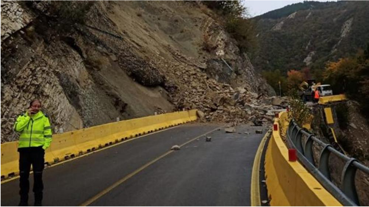
Figura 44: Crollo di massi e detrito in località Armorano. (fonte: Gazzetta di Parma)
