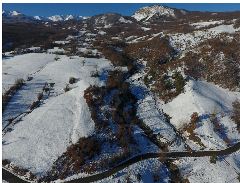
Figura 51: Immagini da drone della riattivazione della frana del Rio della Costa (comune di Villa Minozzo) (foto di G. Bertolini, Agenzia regionale per la sicurezza territoriale e la protezione civile).
