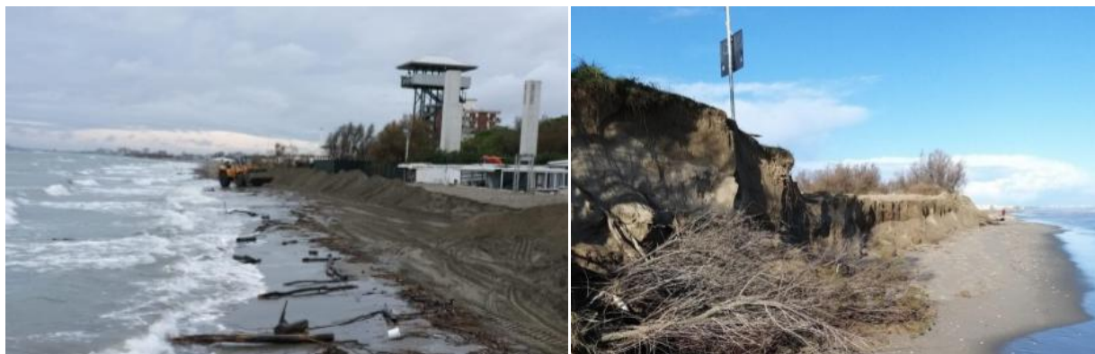
Figura 60: Erosione totale degli argini invernali al Lido delle Nazioni e riduzione della prima linea di difesa a mare (sinistra.) Falesia di erosione nella spiaggia al Lido di Spina (destra). (fonte Protezione Civile)
