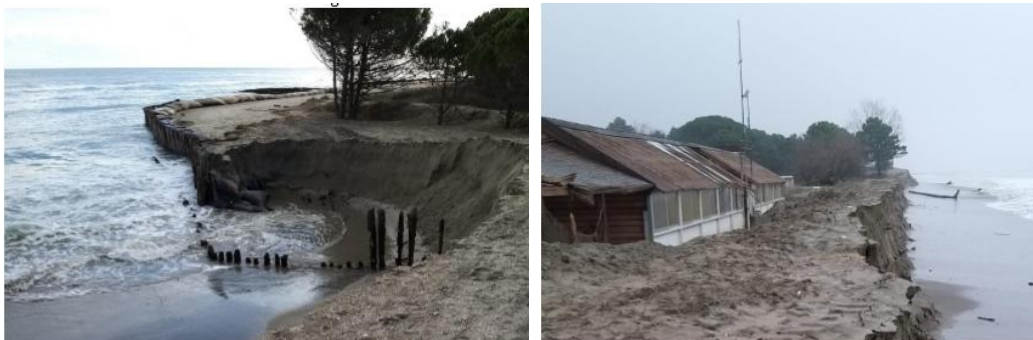
Figura 59: Bagno Isa –Fronte di erosione prossimo all'argine di difesa in sabbia che corre lungo tutta la pineta di Volano, con creazione di falesia di altezza massima di circa 2 m, falesie prodotte a seguito di erosione di argini invernali al Lido di Volano e totale scomparsa della prima linea di difesa a mare (fonte Protezione Civile)
