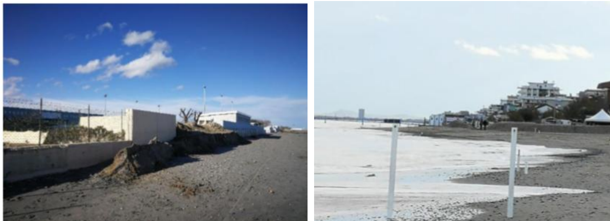
Figura 62: – Cesenatico loc. Ponente, duna abbattuta fronte colonie 12 stelle, a sinistra, San Mauro Mare, abbassamento del piano spiaggia, a destra (fonte Protezione Civile)
