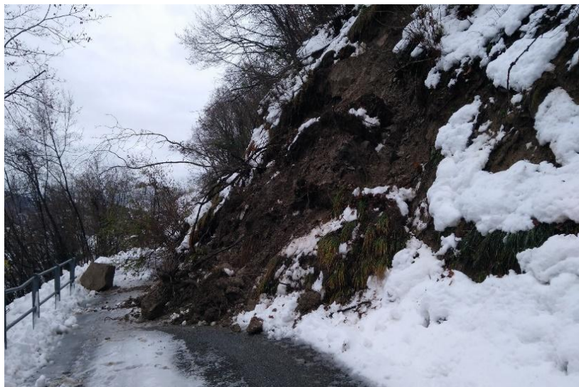
Figura 49: Movimento franoso lungo la strada comunale di Dezza che conduce al Passo del Brallo (comune di Bobbio) (foto Agenzia regionale per la sicurezza territoriale e la protezione civile).
