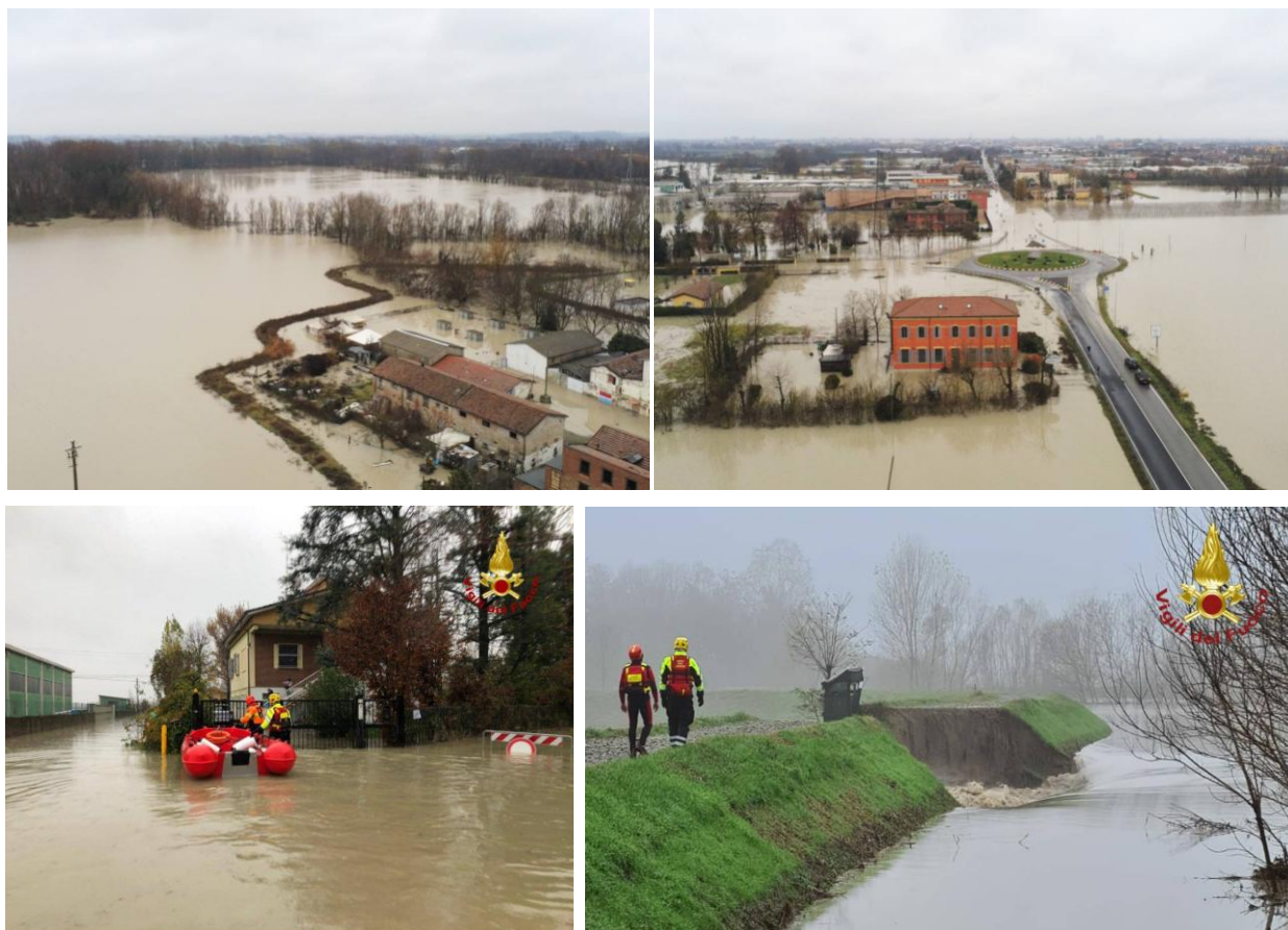
Figura 41: In alto ed in basso gli allagamenti causanti dalla rotta del Panaro (foto Fiocchi, dal Resto del Carlino); in basso a sinistra le evacuazioni a Gaggio (foto Vigili del Fuoco, da Il Resto del Carlino); in basso a destra, la breccia nell'argine in destra (foto Vigili del Fuoco, da Il Resto del Carlino).
