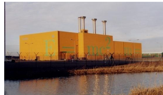
Deposito intermedio di rifiuti ad alta attività nei Paesi Bassi
